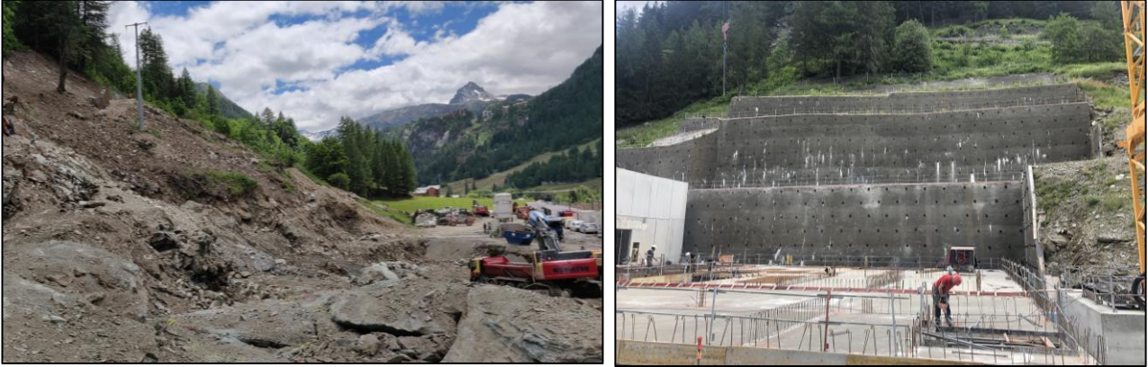
Figure 1. Avant et après travaux de parois clouées - TIGNES LES BREVIERES (73)
