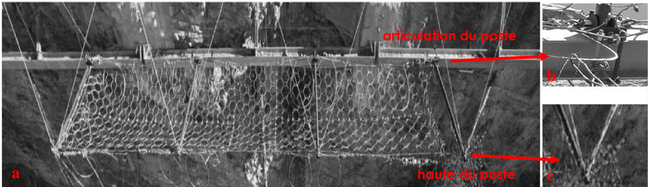
Figure 1 a. barrière souple C2ROP, b. pied de poteau, c. tête du poteau
