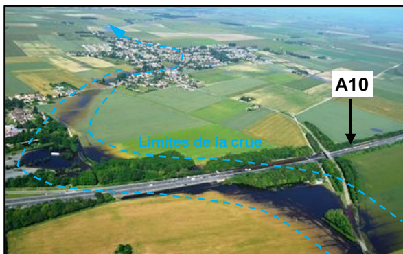
La Retrève à la décrue au niveau de l'A10
