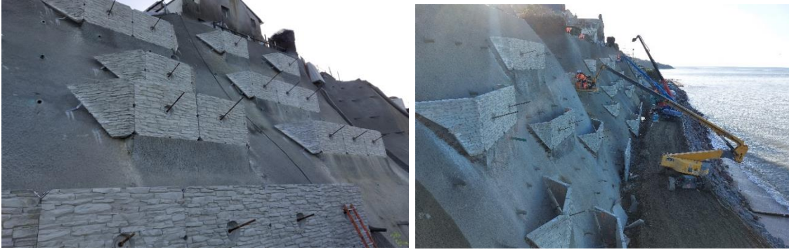
Figure 14 : procédé ADOC® mis en place pour les jardinières
