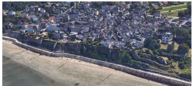
Figure 2 : Vue satellite de la falaise avant travaux
