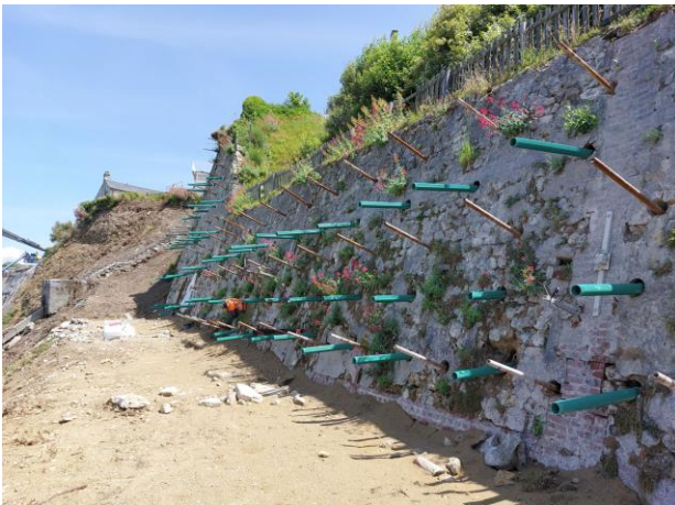
Figure 4 : Réalisation des clous et drains au cours du chantier
