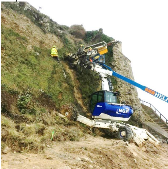
Figure 11 : utilisation de la pelle araignée pour la réalisation de certains forages, glissière lourde équipée sur la pelle de démolition
