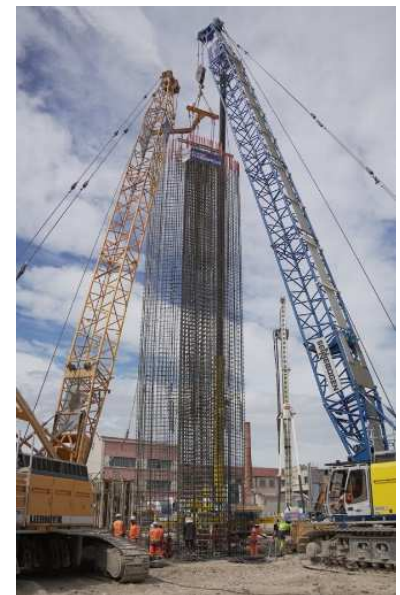
Figure 6 : Aperçus des 4 passes de forage (à gauche) et des armatures des Tés (à droite)
