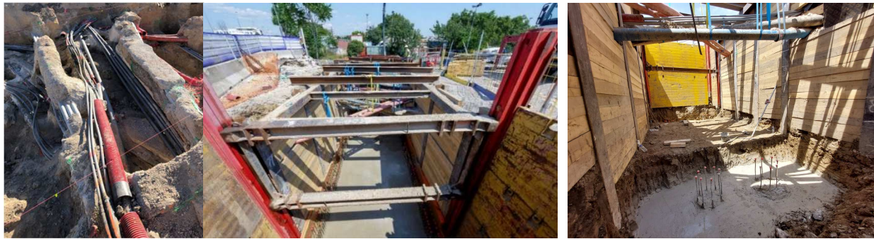
Figure 8 : Soutènement urbain (présence de réseaux, paroi berlinoise)
