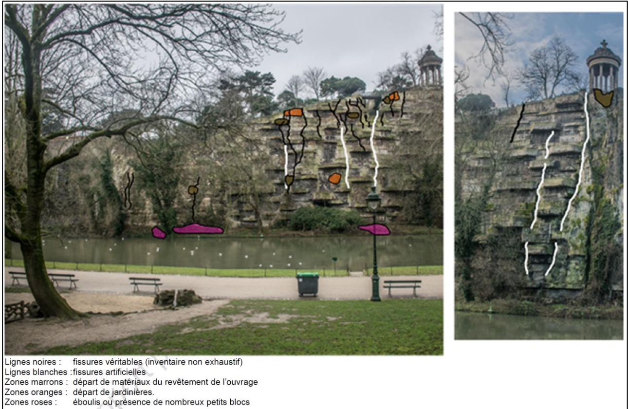
Figure 6. Vue de la paroi est de l'île présentant les principaux éléments de diagnostic du BRGM.
