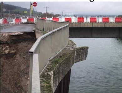
Figure 1 – Rupture de l'ouvrage en 2001
