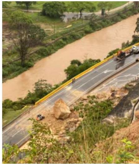
Figure 5. Chutes de blocs observées en mars 2021
