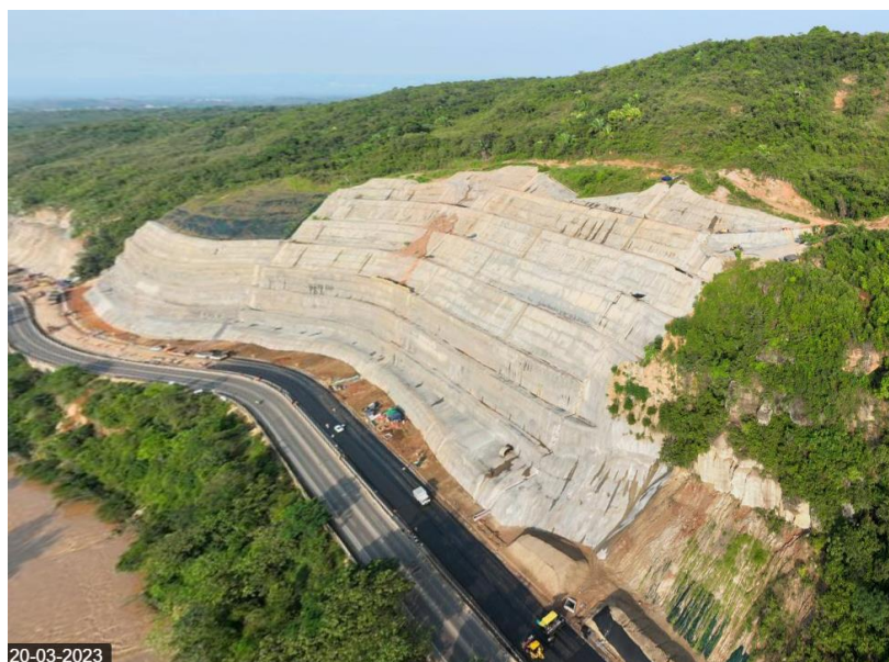
Figure 7. Secteurs 2 et 3 – Travaux finalisés
