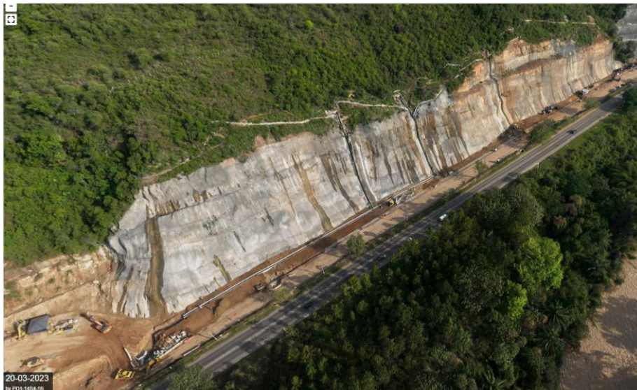
Figure 8. Secteurs 4 à 9 – Travaux terminés
