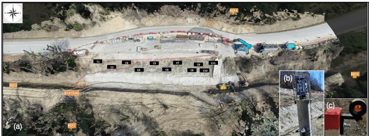
Figure 6. (a) Implantation générale des éléments du dispositif de mesures. (b) Détail de la station de mesure de type Trimble S9. (c) Détail d'une cible.
