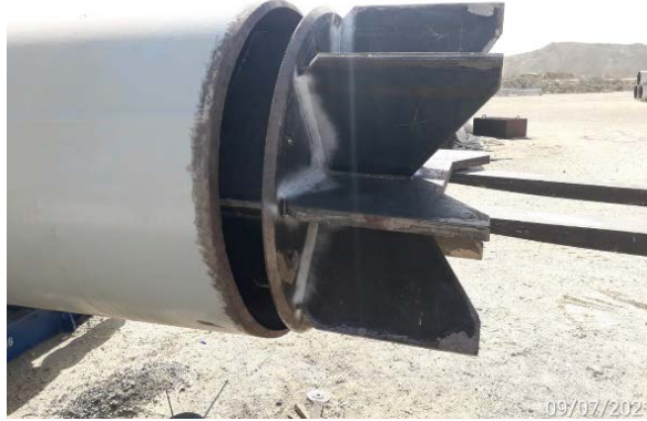
Figure 7. Mise en place d'un diaphragme dans un tube métallique
