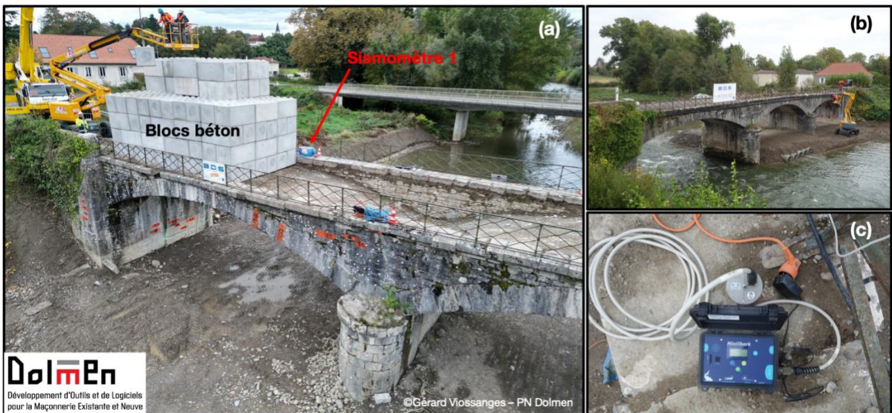
Figure 1. (a) Vue d'ensemble de la voûte chargée du pont d'Osserain, lors de la dernière phase de chargement. (b) Vue d'ensemble du pont d'Osserain, avant chargement. (c) Zoom sur l'instrumentation du sismomètre 1, avec capteur (gris), câble sismologique (blanc) et numériseur (noir).
