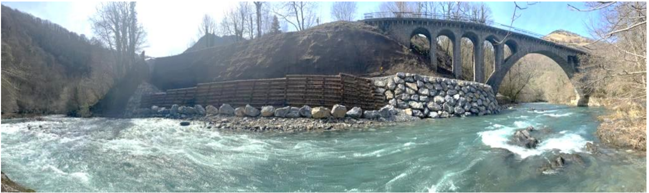
Figure 11. Vue des travaux de confortement achevés
