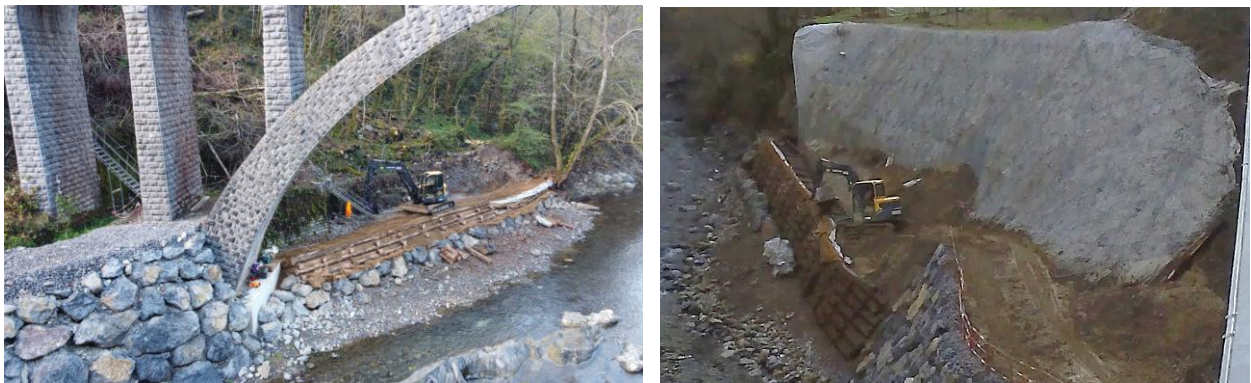
Figure 10. Travaux de confortement par caissons d'arbres et gé grille tridimensionnelle.
