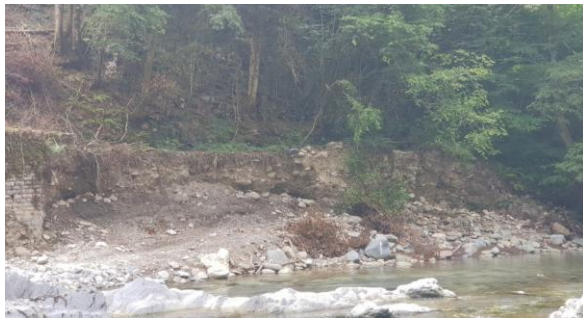
Figure 2. Erosion des berges à l'aval du pont
