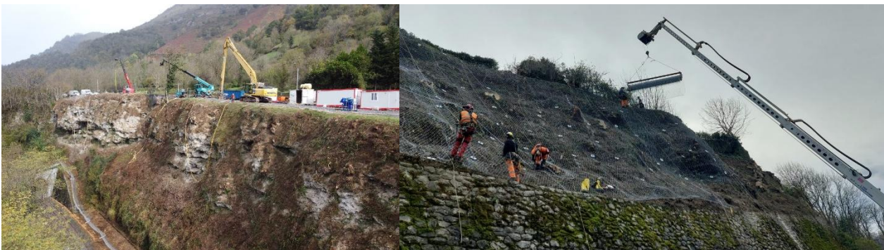
Figure 12. Travaux de confortement en cours de réalisation sur le déblai d'Araou
