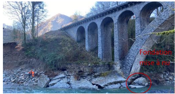
Figure 3. ruine du perré et fondation mise à nu
