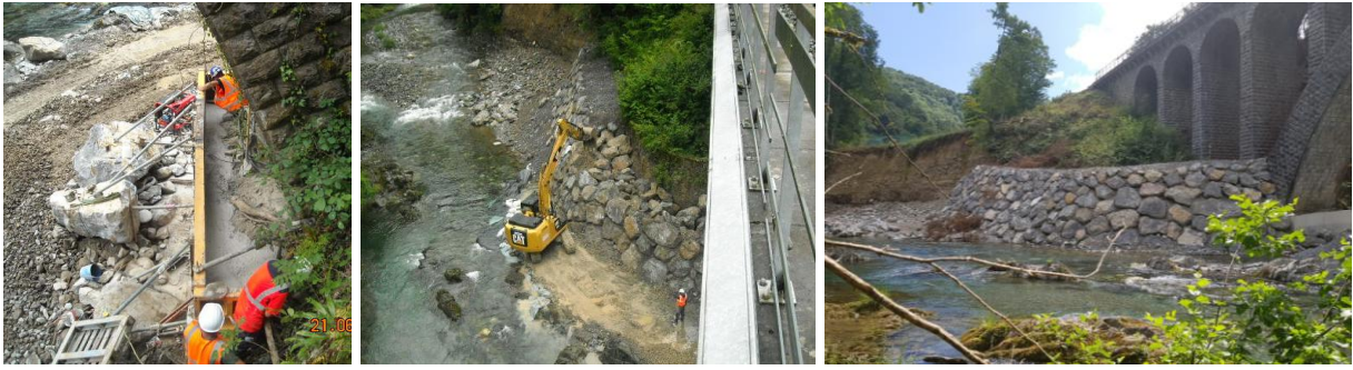
Figure 9. Reconstitution de la protection de la culée et enrochements
