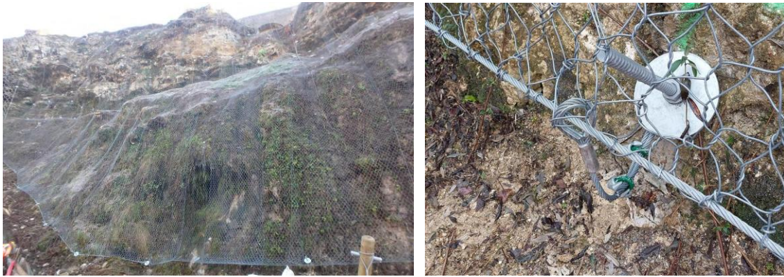
Figure 16. Filet pendu lâche et système de débattement en pied
