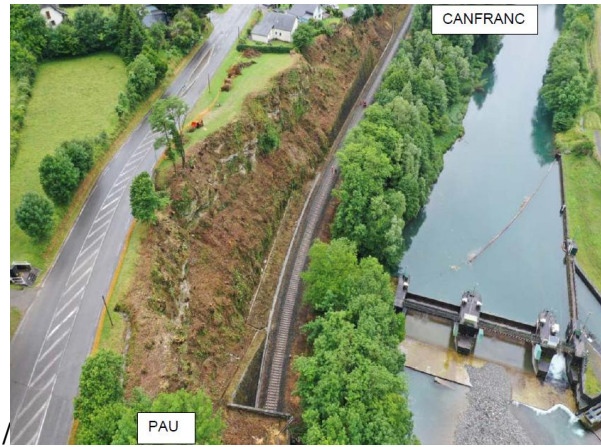
Figure 6. Vue générale du déblai à la sortie du tunnel de l'Araou.
