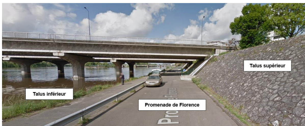
Figure 2. Vue de la digue en rive droite (Google Street View)
