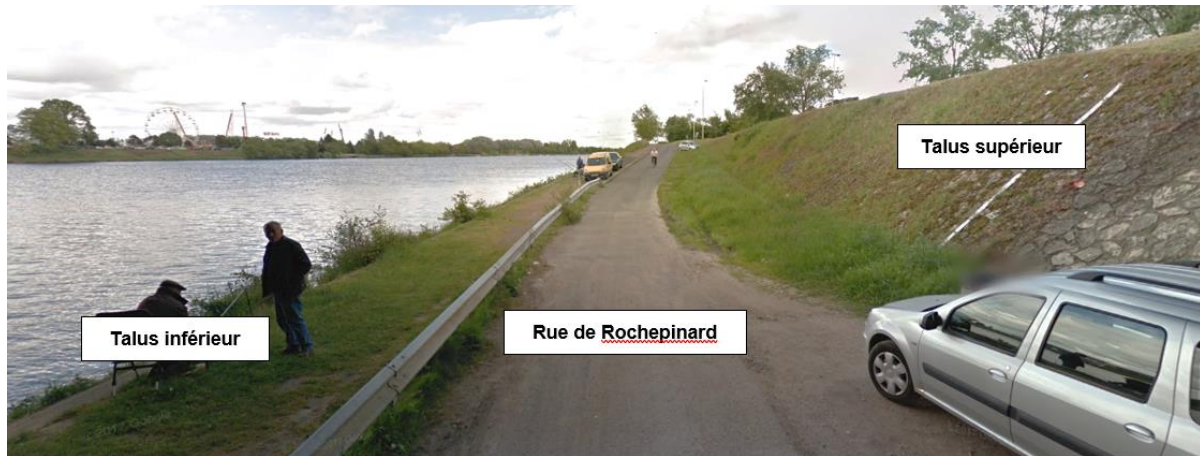
Figure 3. Vue de la digue en rive gauche (Google Street View)
