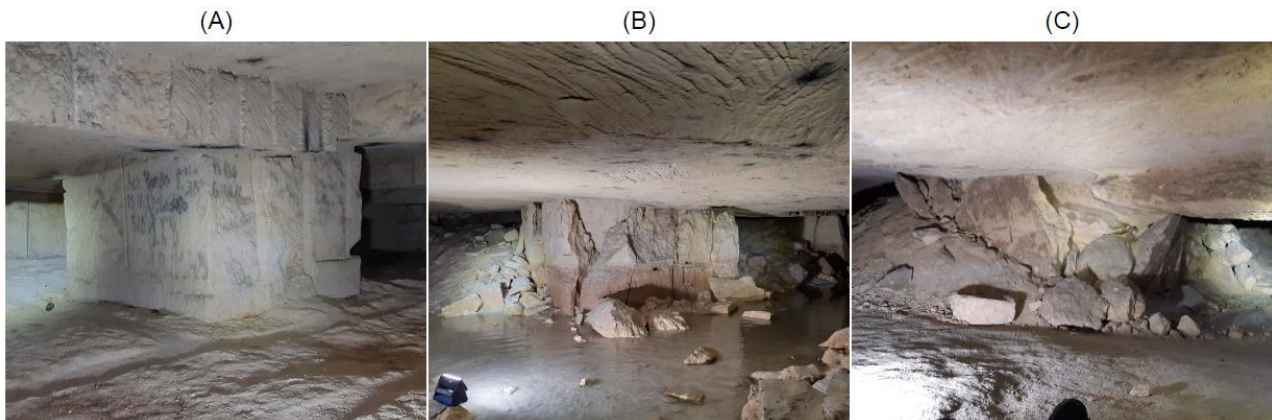
Figure 2. Exemple de piliers illustrant les trois catégories d'endommagement (carrière de Saint-Germain-du-Puch).
