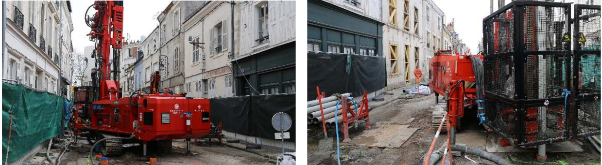
Figure 2. Travaux d'injections solides sur le futur passage des engins de démolition
