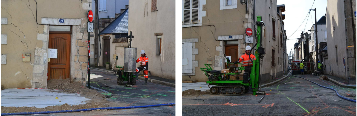
Figure 3. Reconnaissance géotechnique au GEOTOOL dans l'environnement du sinistre
