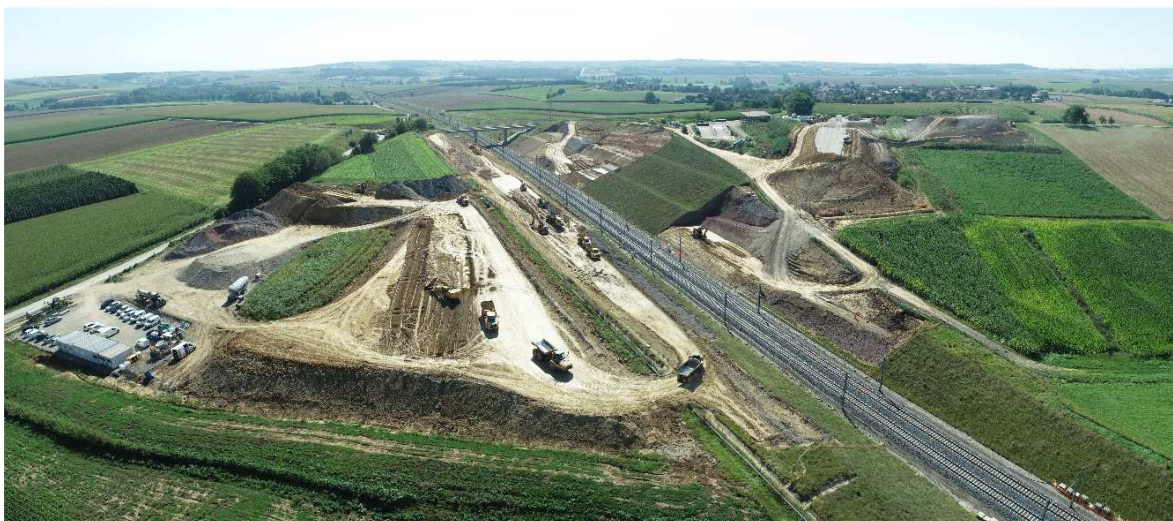
Figure 6. Vue aérienne du chantier le 02/09/2021
