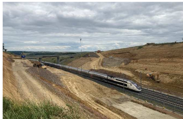
Figure 5. Photo du chantier le 01/09/2021
