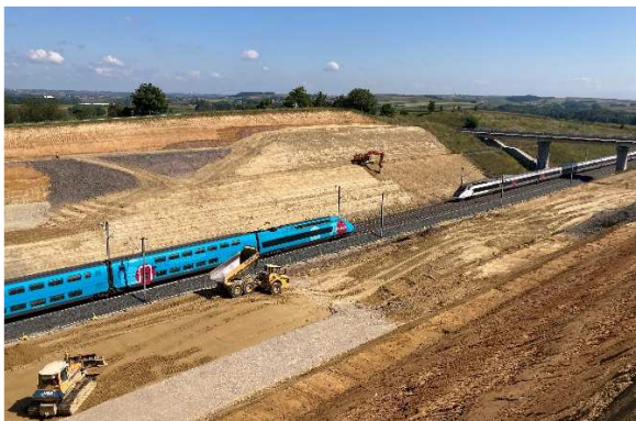
Figure 4 Photo du chantier le 01/09/2021
